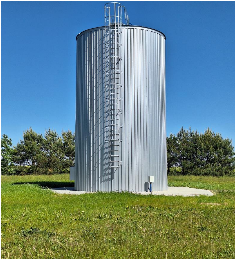
Fot. 4 Zbiornik wyrównawczy na Stacji Uzdatniania Wody Podedwórze
