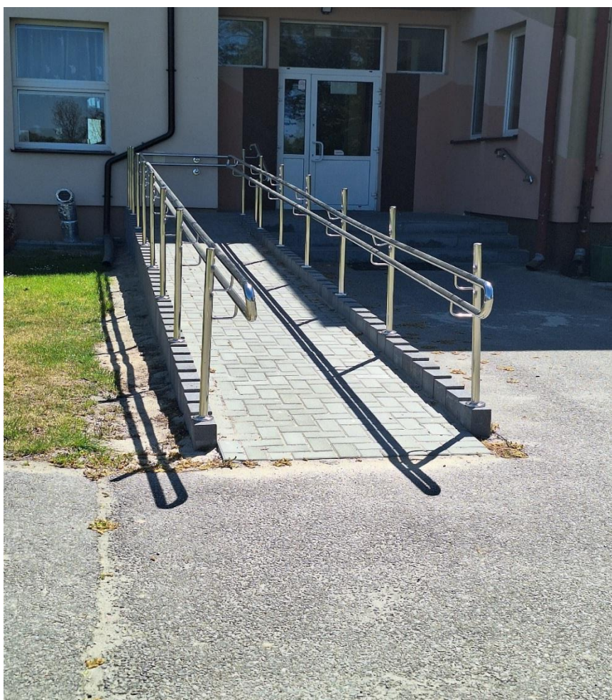
Fot. 8 Budowa pochylni dla osób niepełnosprawnych oraz przebudowa schodów do budynku ZPO
